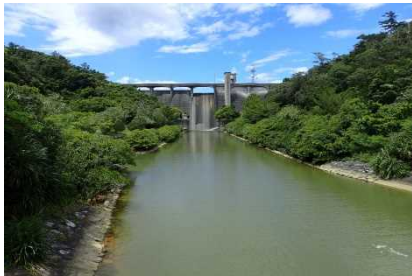
漢那ダム本ダム堤体
