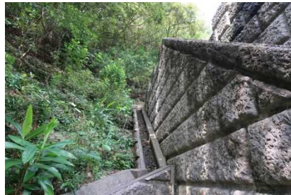
漢那ダム魚道
