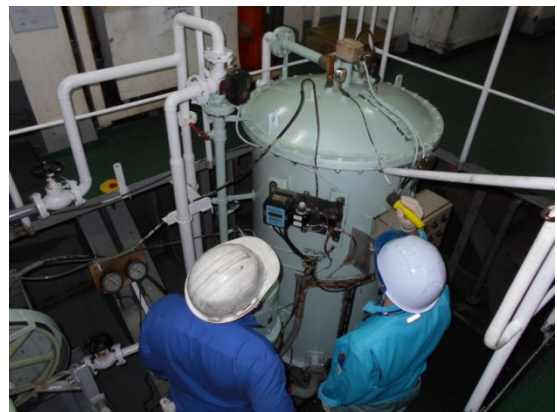
油水分離装置の作動テスト
