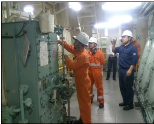
油水分離装置の外観検査及び作動テスト
