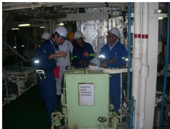
油水分離装置の外観検査及び作動テスト
