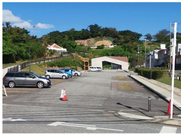
写真 2-3：南エントランス管理事務所
