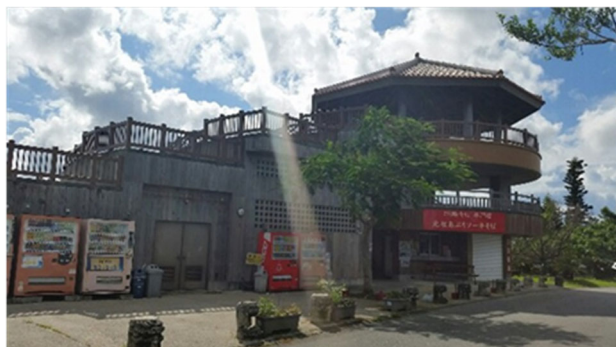
写真 2-4：西エントランス展望台
