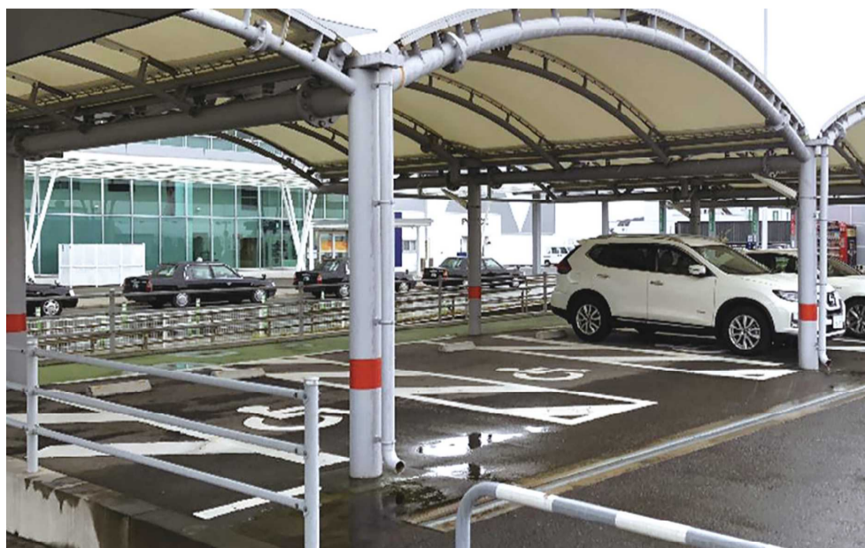
徳島空港 / 空港まで屋根が連続して設置されている障害者用駐車スペース
