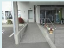
出入口の段差解消 事業費：30万円程度
