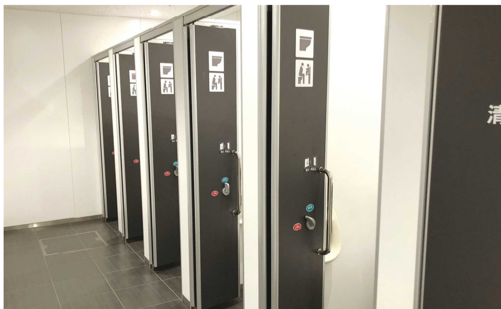
出雲空港／空き状況が確認しやすい折れ戸式ドア
