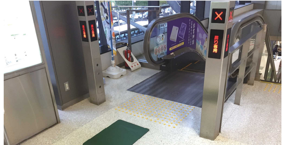
誘導用ブロック(誘導用マット)がエスカレーターの降り口部分に敷設
