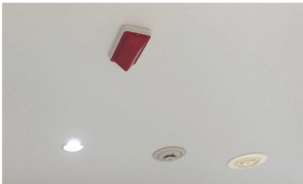
那覇空港／際内連結ターミナル施設2階
