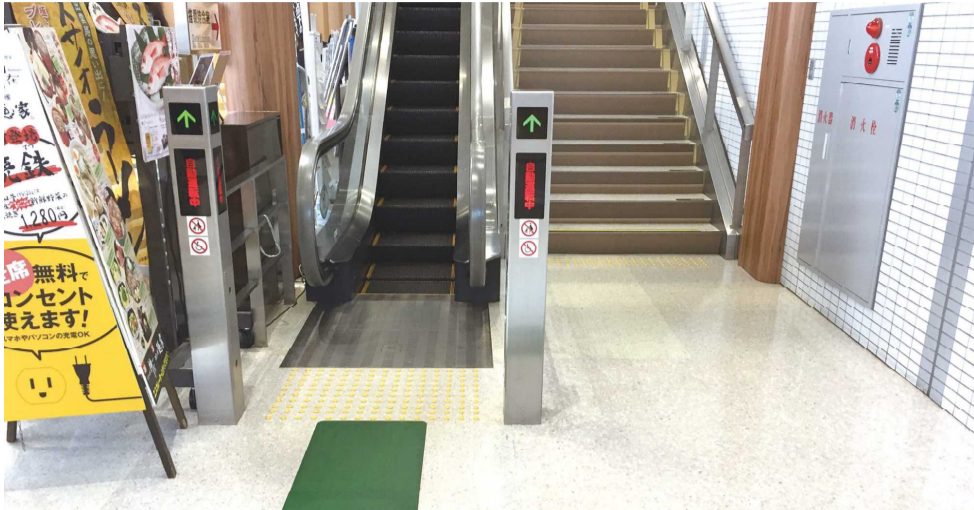
誘導用ブロック(誘導用マット)が階段には敷設されずにエスカレーターのみ敷設
