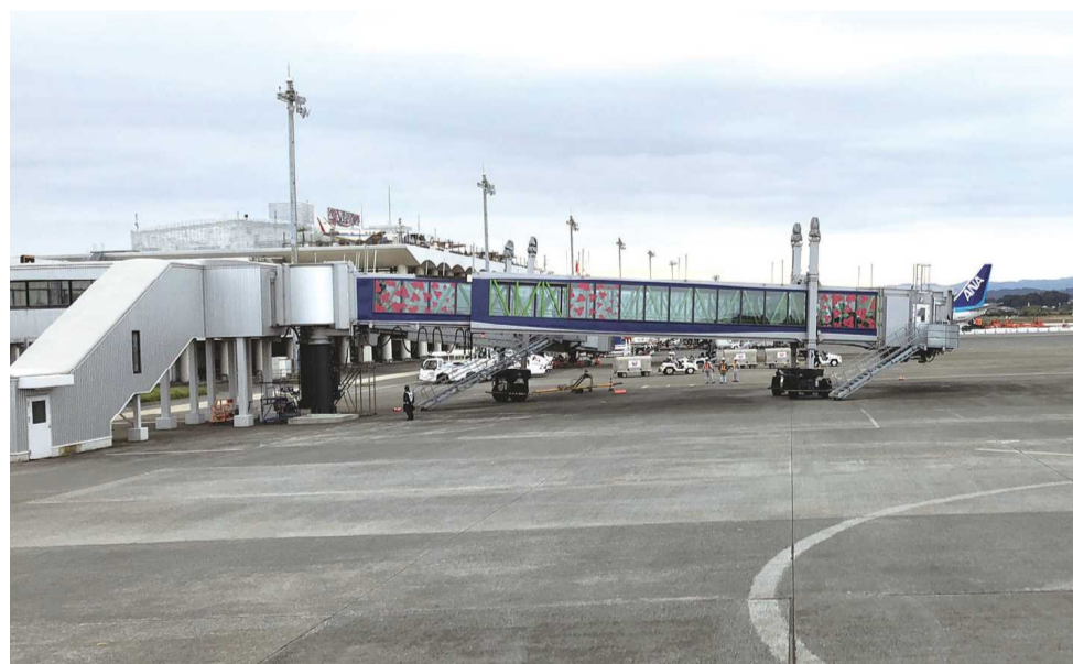
宮崎空港／ロングパッセンジャーボーディングブリッジ
