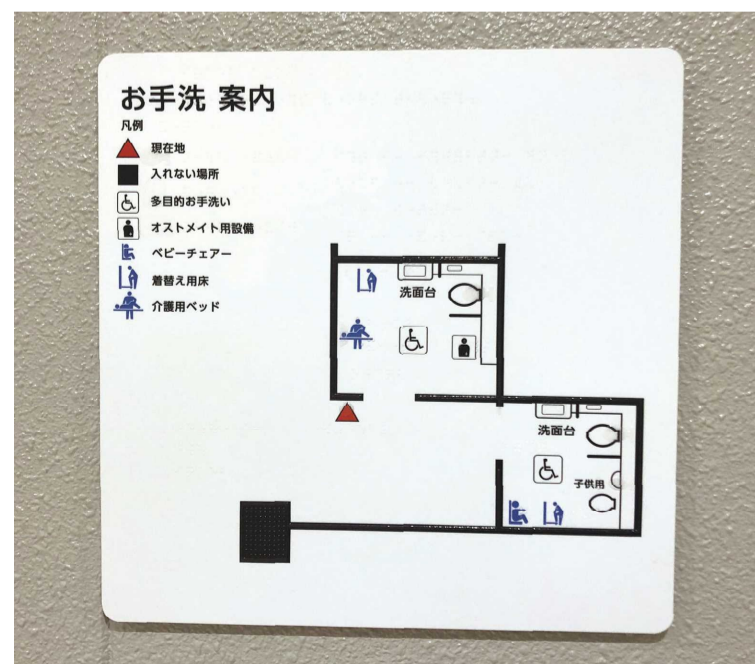
トイレ出入口に設置された触知案内図
