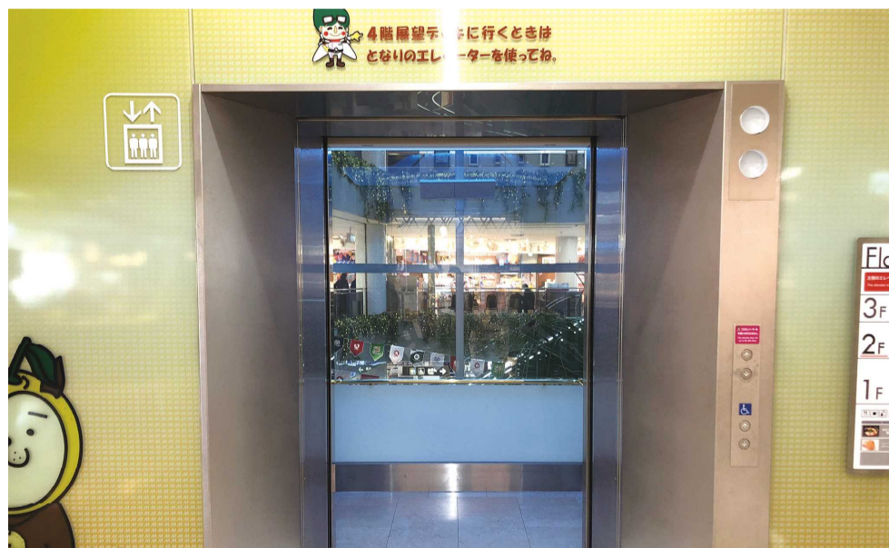
宮崎空港／エレベーターの増設
