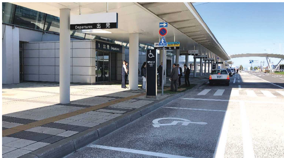
シンボルマークが横向きに表示され車両からの視認性が悪い路面表示
