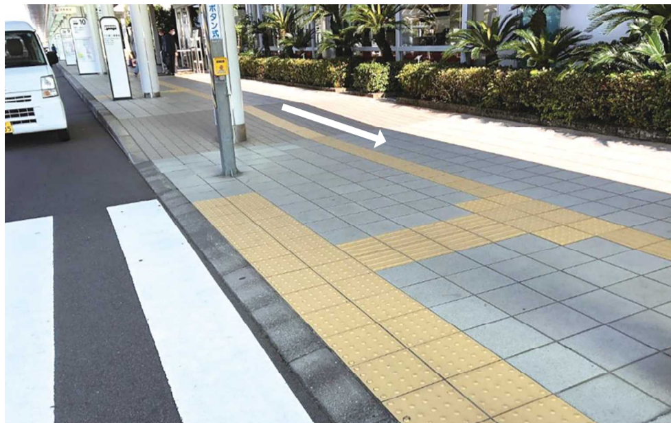
鹿児島空港 / 視覚障害者誘導用ブロックの適正敷設及び勾配処理により安全性が高められたカーブサイド
