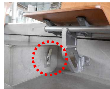
集団補聴設備の設置
