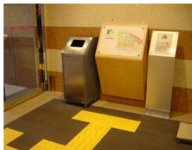
視覚障害者誘導用ブロック、点字による案内板の設置
