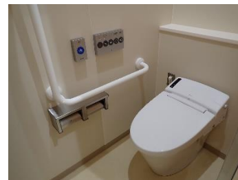
大便器用手すり
