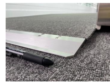
トンネル間を接続するスロープの勾配は1/30と極めて緩やかで、スロープ端部の段差もほとんどない
