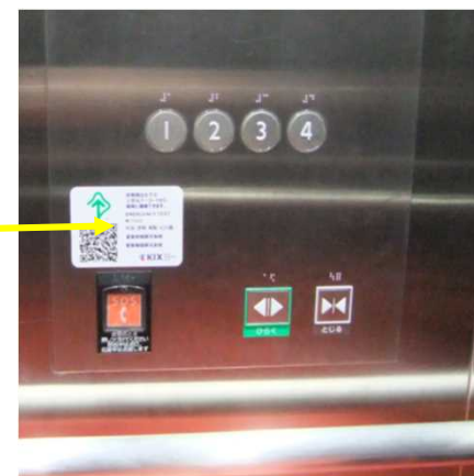
エレベーターカゴ内 操作盤に2次元バーコード が貼付られている
