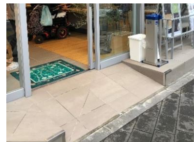
スロープの設置
