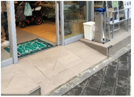
スロープの設置
