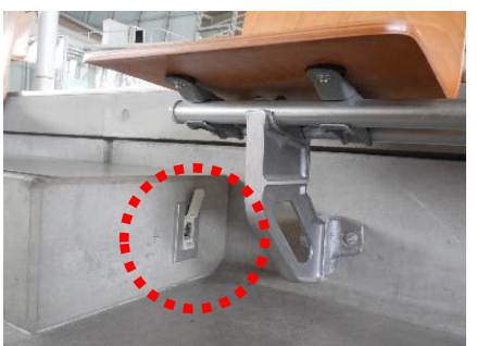
集団補聴設備の設置
