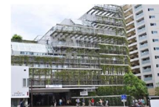
大岡山駅(駅外観)
