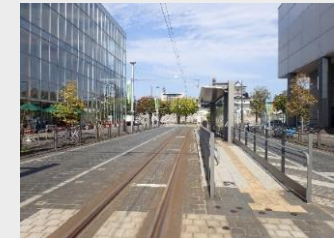
傾斜路の設置(富山鉄 国際会議場前駅)
