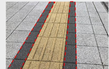
視覚障害者誘導用ブロックの輝度比を確保した事例
