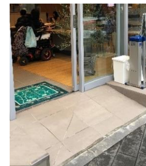
スロープの設置
