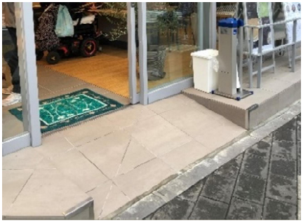
スロープの設置
