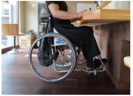
ローカウンターを設置
