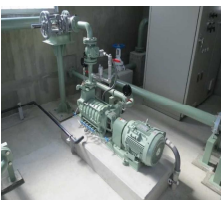
ウカバ揚水機場
