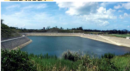
千原貯水池（地表貯水部）
