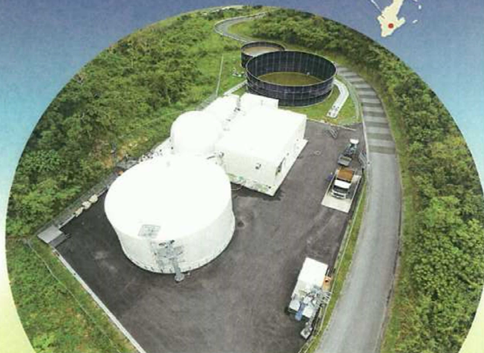
八重瀬町バイオガスプラント
