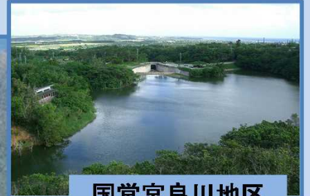
国営宮良川地区 石垣ダム
