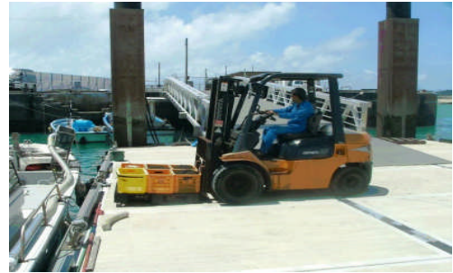
浮棧橋整備後
