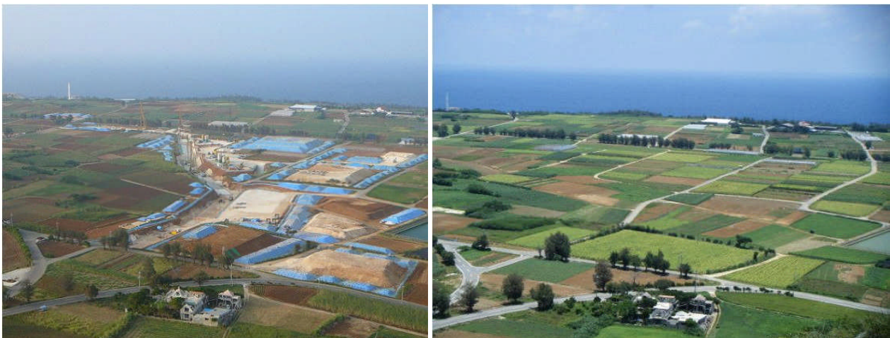
地下ダムの工事 (伊江地下ダム) (左：工事中、右：工事完了後)
