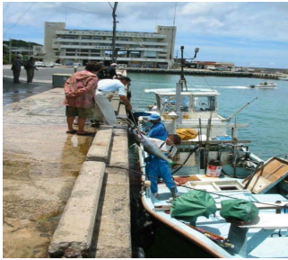
浮棧橋整備前
