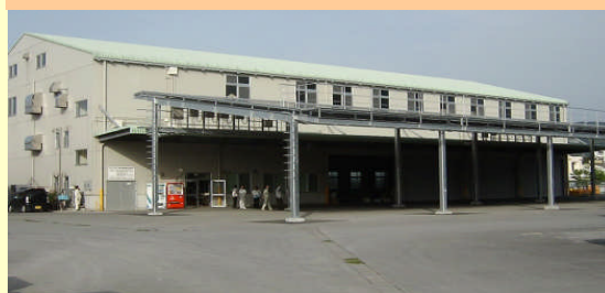
貯蔵選果場 （手前の架台にパネルを設置）
