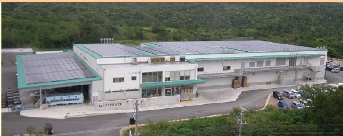
東村総合農産加工施設（屋根に太陽光パネル設置）
