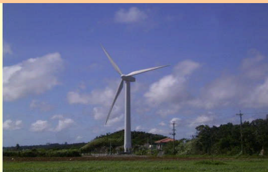
風力発電施設
