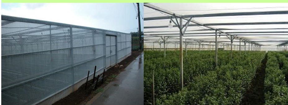
農作物被害防止施設（平張施設）
