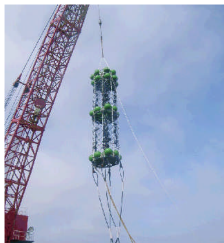
中層型浮魚礁（沖縄県伊平屋村） (写真提供：沖縄県)
