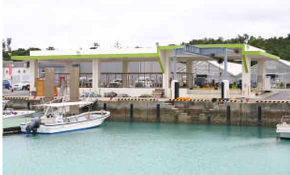
増養殖用作業保管施設 (前兼久漁港)
