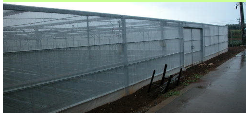
農作物被害防止施設（平張施設）
