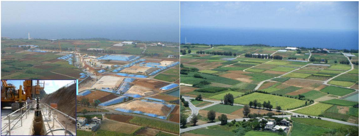
図 VI-2 地下ダムの工事 (伊江地下ダム) (左: 工事中、右: 工事完了後)
