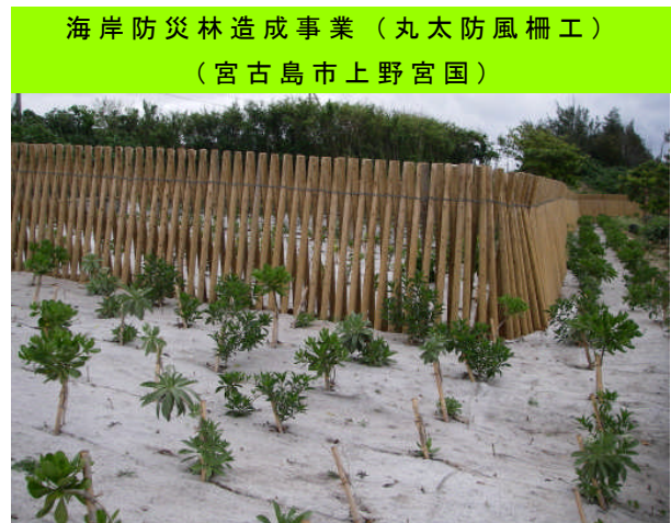
海岸における飛砂害、潮害等を防止するために、海岸でも成長の良いテリハボク等の苗木を植栽し、その苗木の成長を保護するための丸太による防風柵を設置しています。
