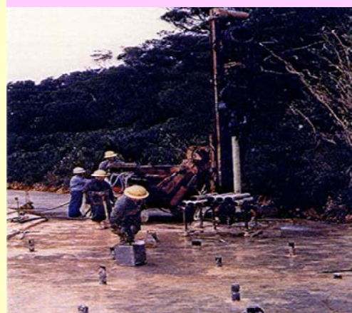
地下ダム竣工（注入工法）
