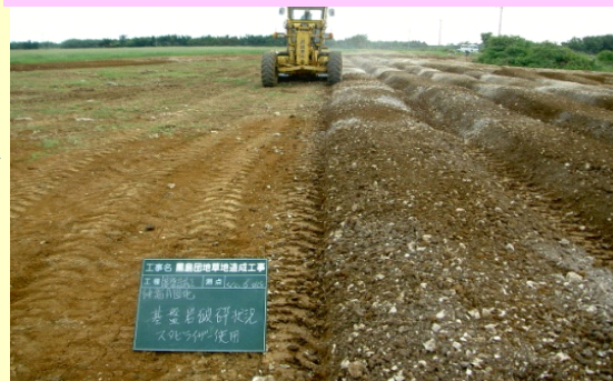
スタビライザー工法により造成された農地
