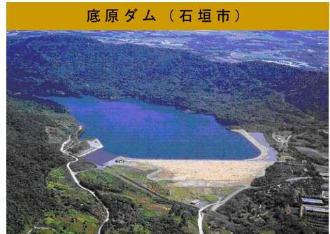
老朽化した施設
