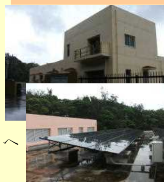
処理施設と太陽光パネル
