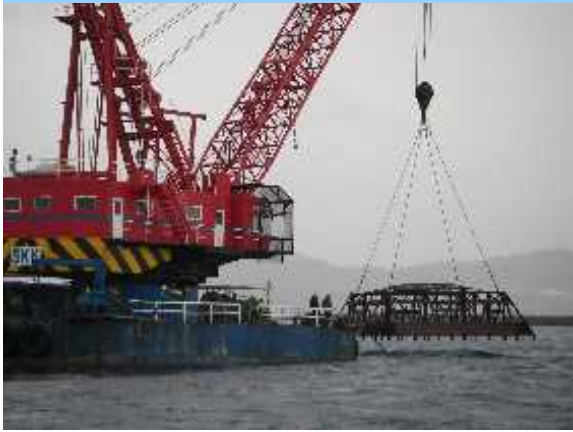
沈設魚礁設置（石垣市）
