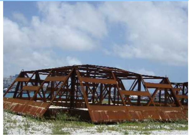
沈設魚礁（石垣市）
