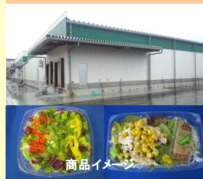
完成したスチーム野菜工場
