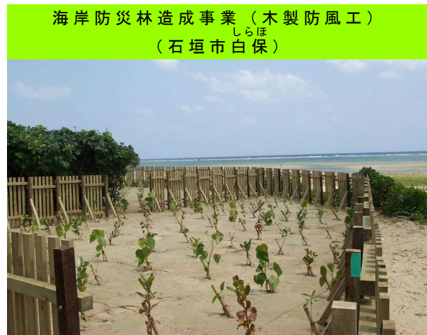
海岸における飛砂害、潮害等を防止するために、海岸でも成長の良いテリハボク等の苗木を植栽し、その苗木の成長を保護するための防風工を設置しています。
