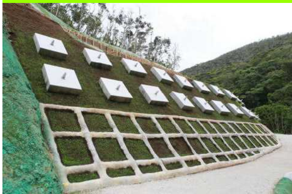
予防治山事業（法枠工・アンカー工） （名護市幸喜）
