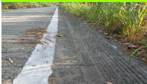
環境に配慮した林道（左：L字型側溝、右：既設U字型側溝の改良）
