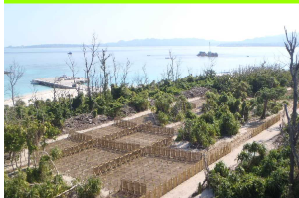
海岸防災林造成事業（木製防風工） （本部町瀬底（水納島））
