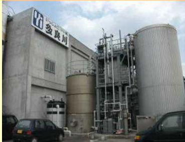
メタン発酵施設
