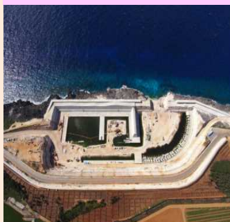
南大東漁港(北大東地区)整備状況
