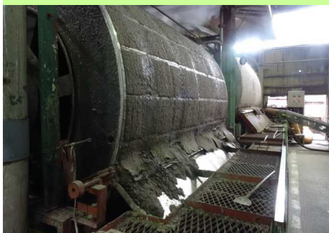
フィルターケーキの分離状況 (うるま市)
