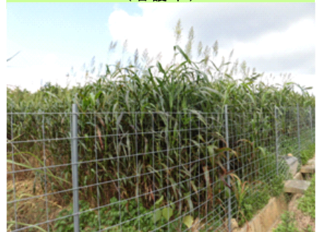
イノシシ侵入防止柵の設置状況 (名護市)
