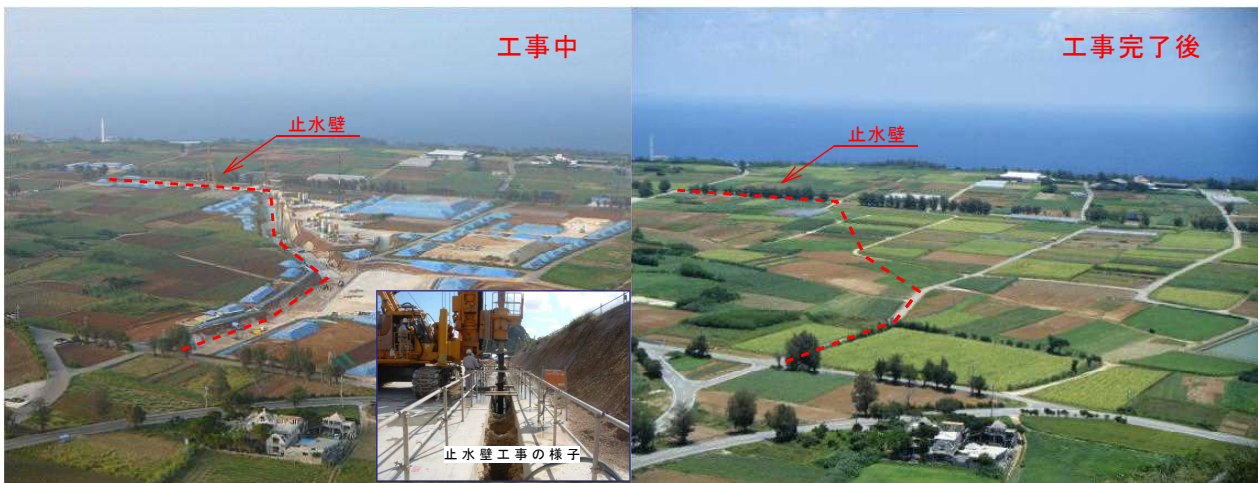
地下ダムの工事 (伊江地下ダム)
