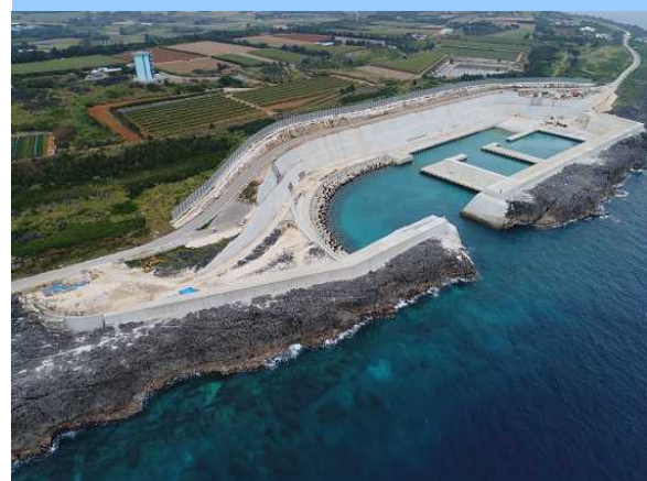
南大東漁港（北大東地区）整備状況
