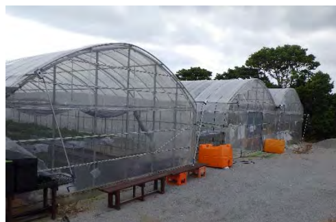
耐候性の鉄骨ハウス
