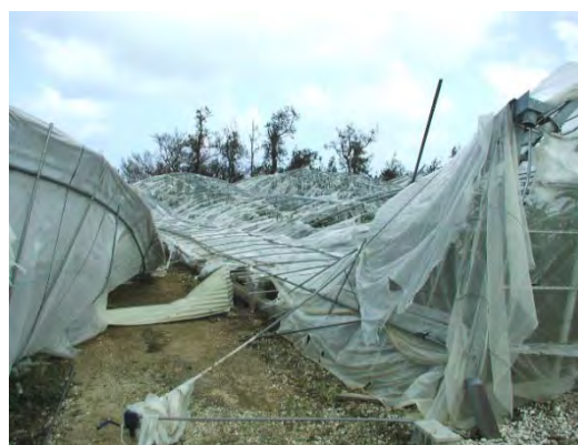
写真 7-2 倒壊したマンゴー栽培のハウス
