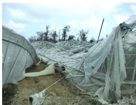
写真 7-2 倒壊したマンゴー栽培のハウス
