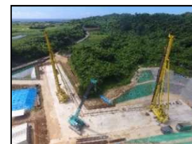
地下ダム止水壁の施工
