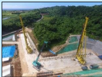
地下ダム止水壁の施工
