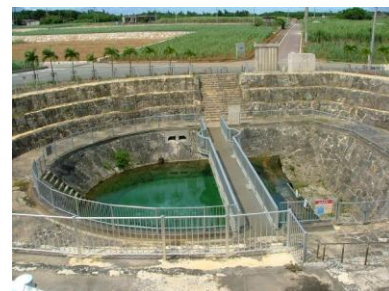
福里地下ダム(宮古島市)水位水質観測施設
