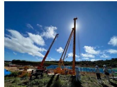
仲原地下ダム(宮古島市)施工状況
