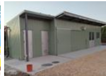
整備した休憩室兼作業施設
