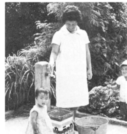
市内に設置された共同給水栓（昭和28年）
