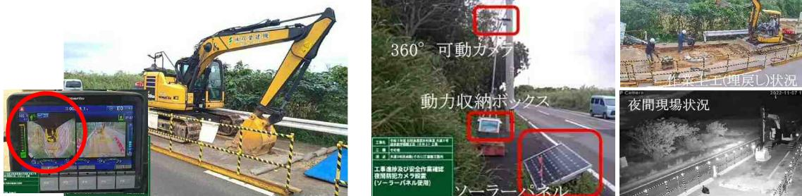
・人検知衝突軽減システムによる接触災害防止
