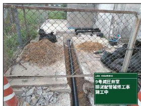
減圧弁室排泥管補修作業
