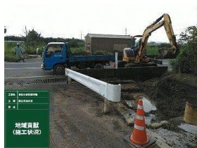
集水枡土砂除去作業
