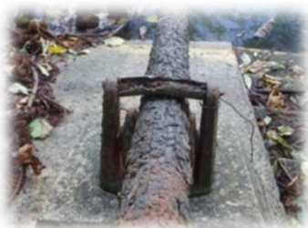
取水施設の腐食
