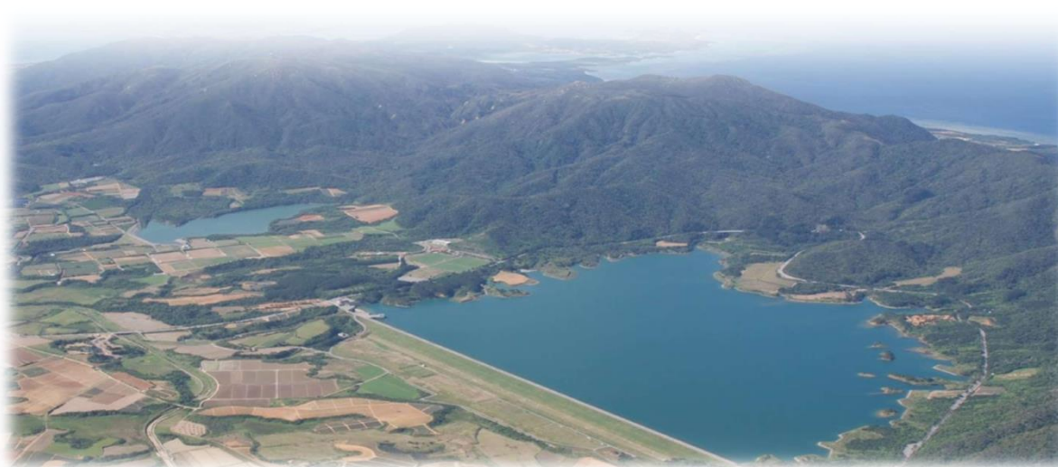
底原ダム(農業用のロックフィルダムで日本一長い堤長のダム)
