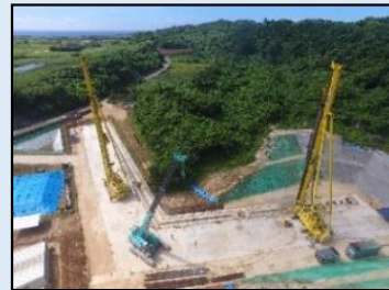
地下ダム止水壁の施工
