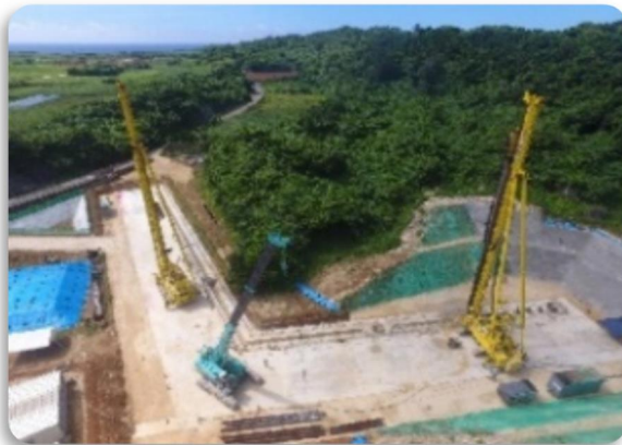
地下ダム止水壁の施工
