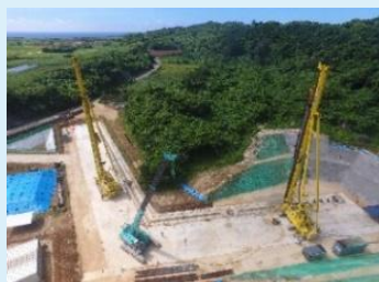
地下ダム止水壁の施工
