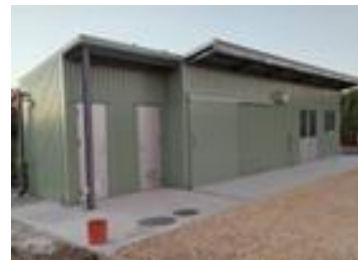
整備した休憩室兼作業施設
