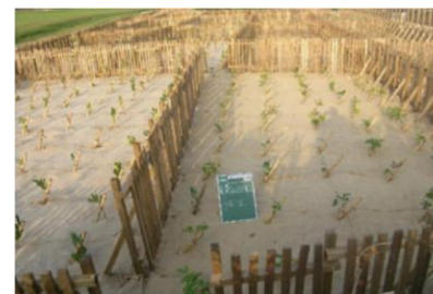
▲防災林の造成（木製防災工）
