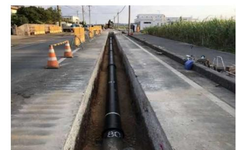
既設用水管(VP管)撤去状況
