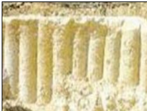
造成された止水壁の様子
