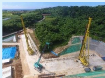
地下ダム止水壁の施工
