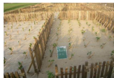
▲防災林の造成（木製防災工）
