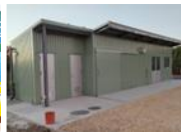
整備した休憩室兼作業施設
