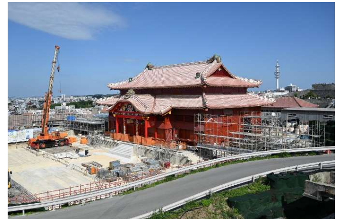
復元整備中の正殿(R7.12.8撮影)
