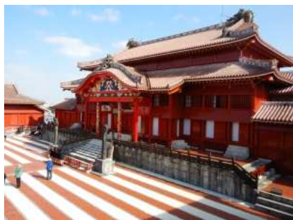
首里城正殿(火災前) (首里城地区)
