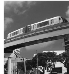
延伸する沖縄都市モノレール
