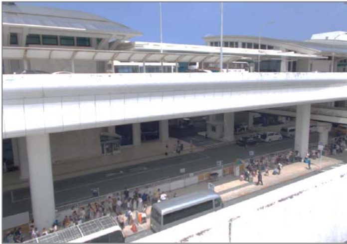
⑤ 1 0 番のりば（P1 立体駐車場屋上より撮影）
